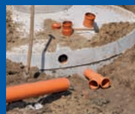
Verfüllen und einfaches Anschließen der Versorgungsleitungen durch serienmäßig eingesetzte KG-Muffen.
