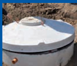
Auflegen des Konus unter Verwendung des Fugenmörtels NORDBETON POTTDICHT®.
